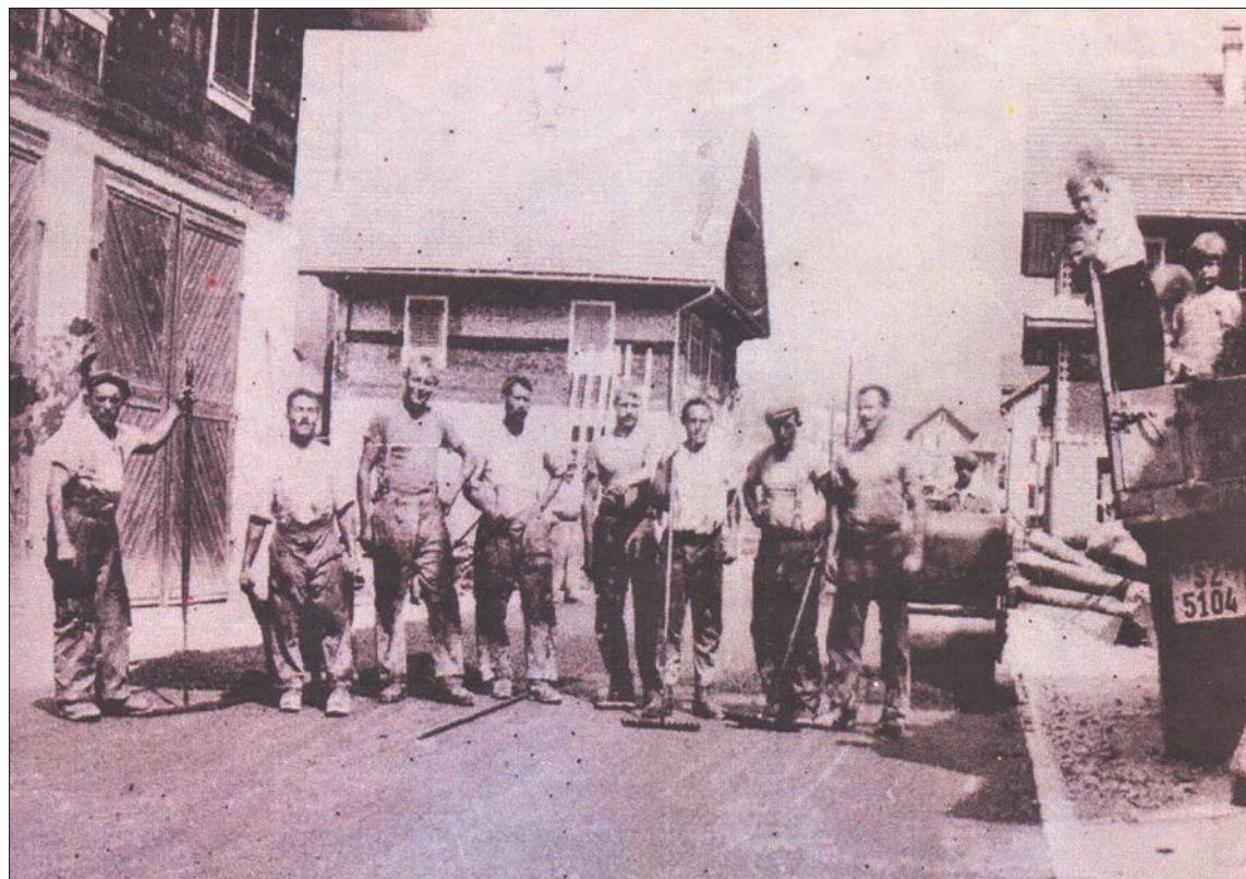
Mit mehr Muskelkraft an gleicher Stelle: Bereits vor 86 Jahren fanden Belagsarbeiten im Bödli an der Schwelle zur Hürbachbrücke statt. Von links: Adolf Schelbert (1903, ds Rösslis), Alois Schelbert (1902, ds Schelbertlis), daneben Arbeiter der Firma Saredi. Auf dem Lastwagen: Emil Hediger (1930, ds Försters) und Martha Hediger (Jg. 1934, ds Försters).
