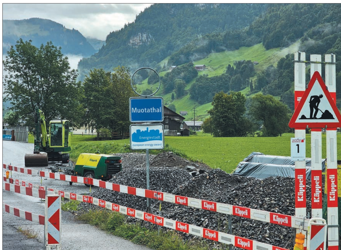
Auch in den nächsten Jahren Alltag: Die Bauarbeiten an der Muotathaler Hauptstrasse dauern einige Zeit und verlangen von den Beteiligten und Betroffenen Geduld.
