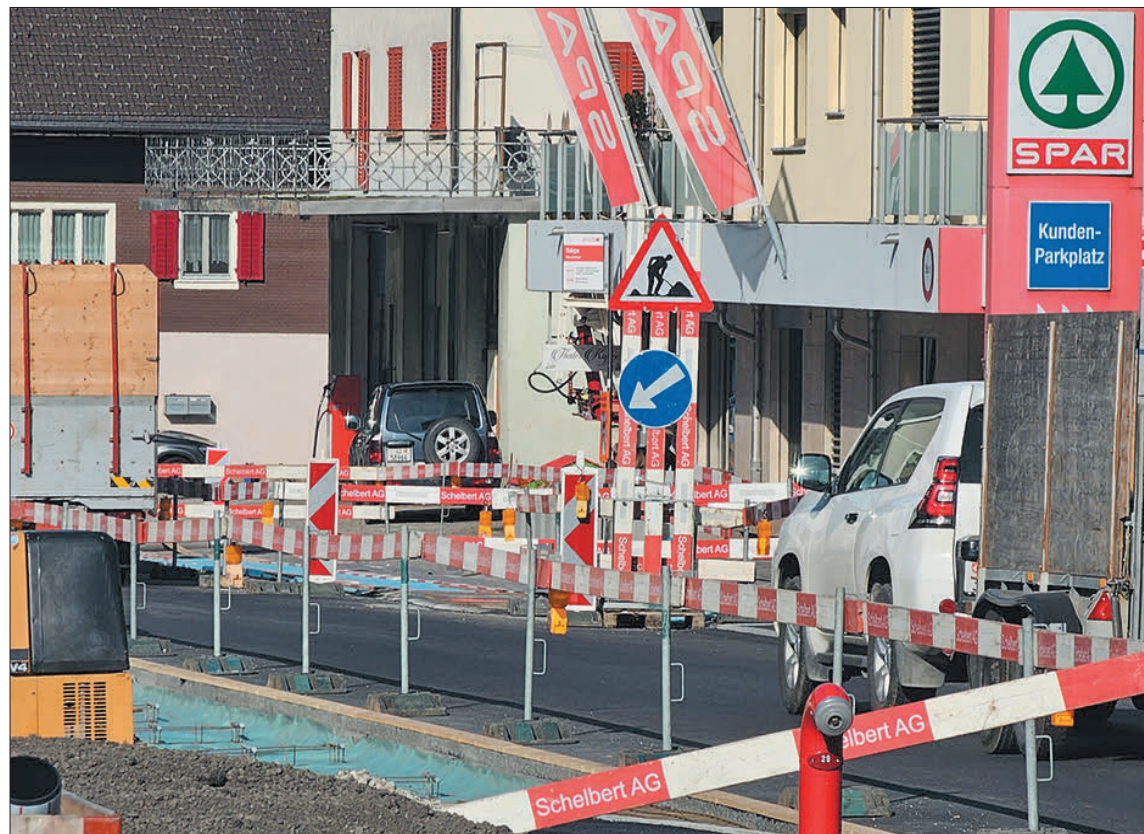
Mässig einladend: Die engen Einfahrten während der Bauzeit sind – insbesondere für Ortsunkundige wie etwa Touristen – herausfordernd zu finden. Foto: Philipp Betschart
