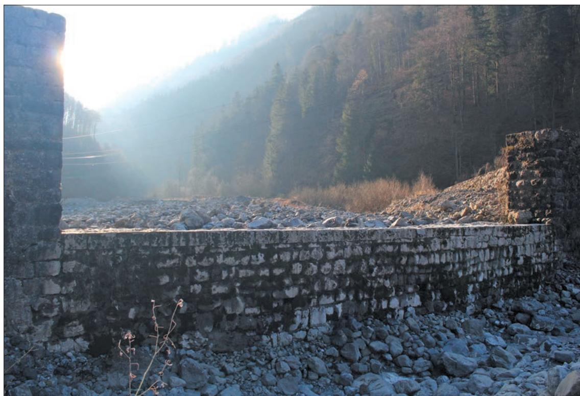
*Die Höch Murä ausgangs Bisistal: Nach dem verheerenden Hochwasser 1910 wurde sie errichtet. Sie stellt den mehrstufigen Eingangstrichter für die folgende Verbauung der Muota talauswärts dar.*
