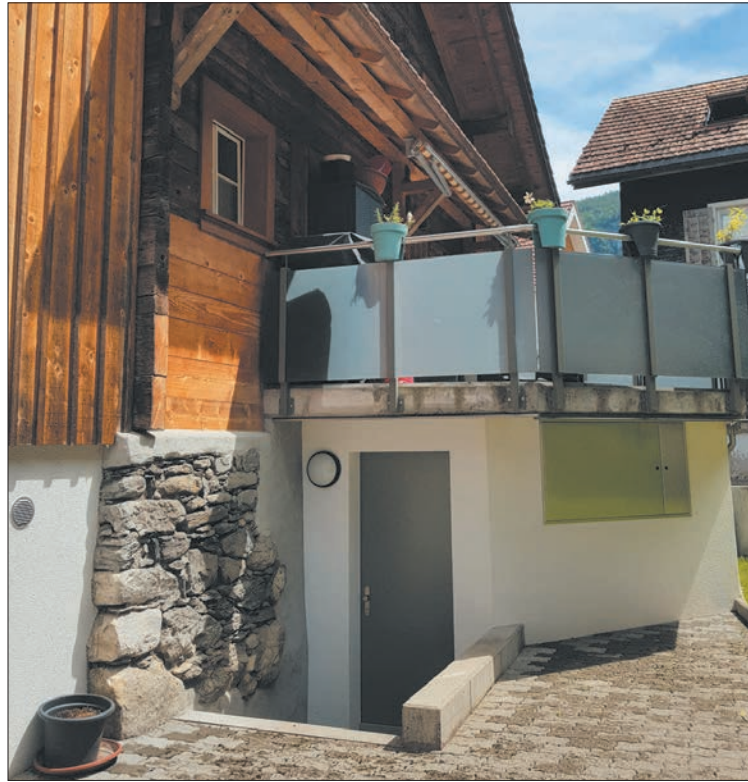
Die alte Grundmauer von 1764, und direkt darüber ein moderner Balkon: Im «Lunnis Huus» ist an der Rückseite ein Teil der Originalmauer zu sehen. Foto: Laura Inderbitzin
