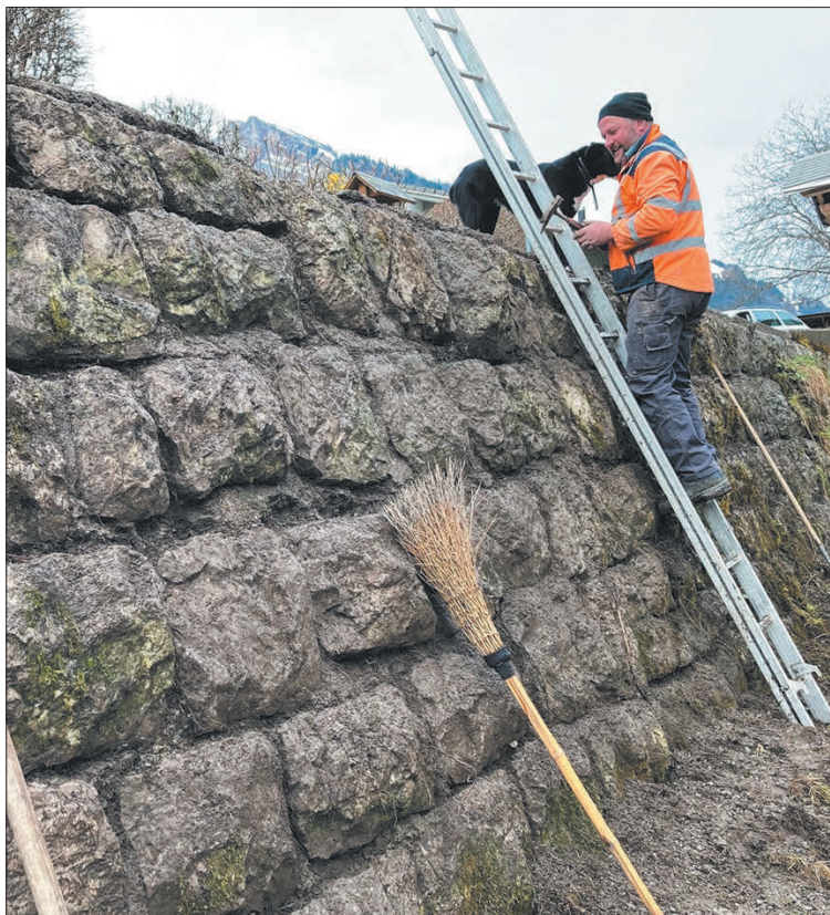
Roman Ulrich (ds Jöris) bei der wichtigen Reinigung der Mauer. Stauden und deren Wurzelwerk müssen fein säuberlich entfernt werden. Foto: Walter Imhof
