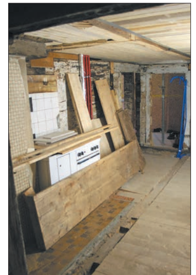
Altbausanierungen stellen die Bauherren und -leute vor Herausforderungen: Blick in das Innenleben anlässlich der Umbauten im Riedter Neuhaus.
