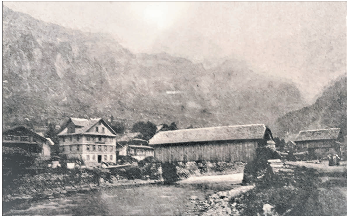
Die Situation bei der hinteren Brücke um 1885. Ein ungenügend befestigtes Ufer und eine fragwürdig errichtete Holzbeige an der Muota sollten vor den Gefahren schützen. Foto: Sammlung Walter Imhof
