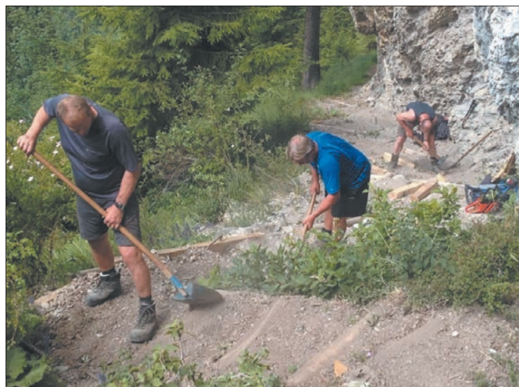
Unterhaltsarbeiten im Gross Band: Das Auswechseln von morschen Tritten gehört zur Aufgabe eines Weggöttis. Hier sind Willi (von links), Mile und Urs an der Arbeit.
