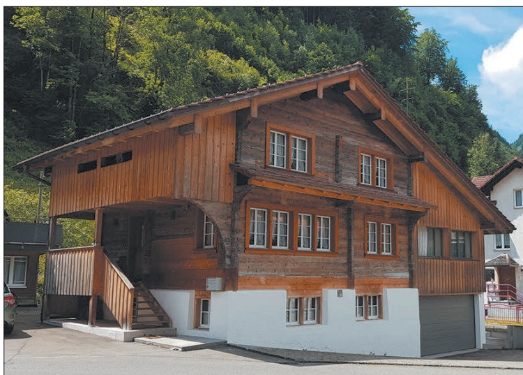
Der Erhalt der Fenster war entscheidend für die Denkmalpflege. Das umgebaute «Lunnis Huus» an der Hauptstrasse 150 verfügt noch heute über die Fenster aus dem Jahr 1764.
