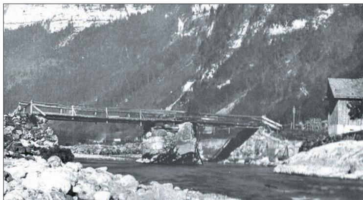
Die vordere Brücke querte ehemals die Muota über einen gewaltigen Felsblock. Dieser wurde nach dem Hochwasser gesprengt. Der Felsblock in der Muota lenkte die Wassermassen an die beiden Ufer und unterspülte die Brückenköpfe.
