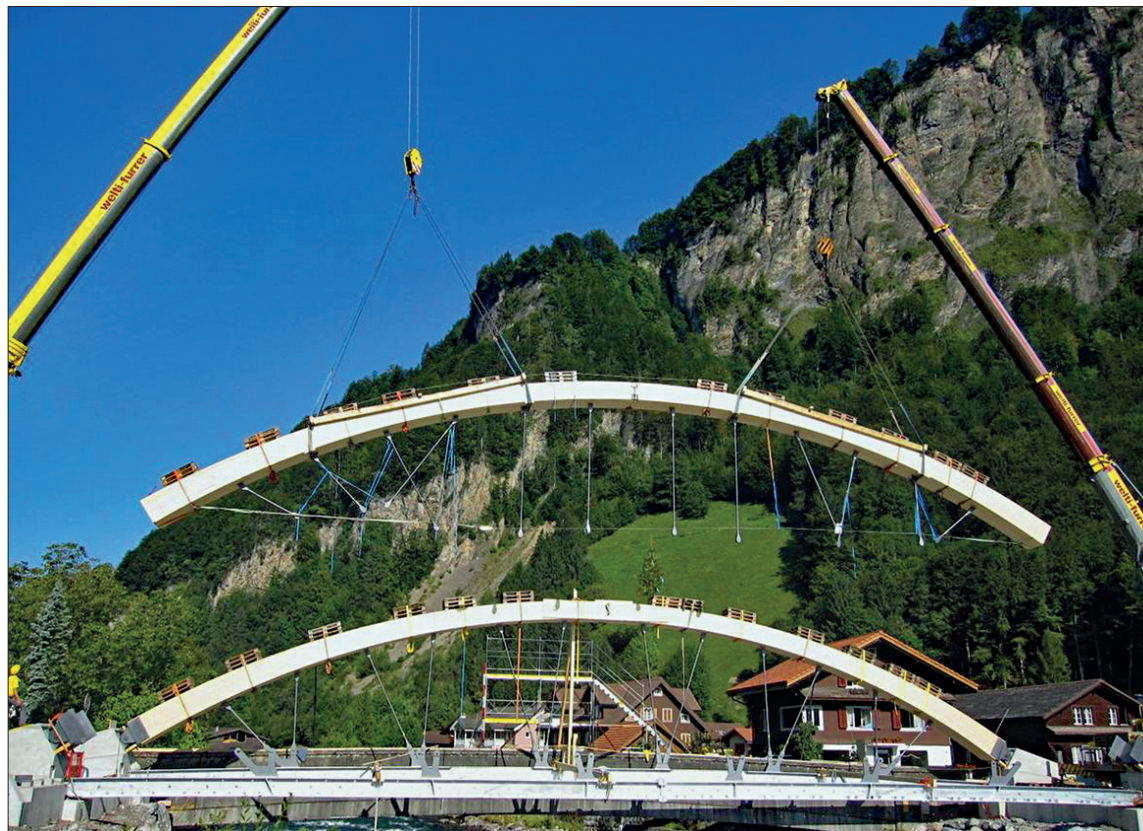
Montage der Kirchenbrücke im Jahr 2010: Die imposanten Holzträger werden mit zwei Kränen in Position gebracht.
