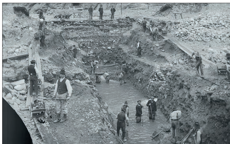
Bau der «Höch Murä» nach dem Hochwasser 1910. Muskelkraft und Einsatzwille waren da gefragt.
