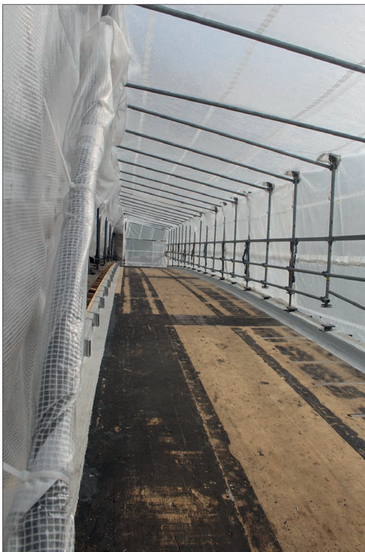
Für die Sicherheit der Fussgänger: Blick auf den freigelegten Teil der Brücke mit den Fahrbahnplatten aus Holz, welche im Zuge der Arbeiten abgedichtet wurden.
