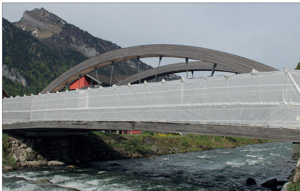
Eingepackt für die Arbeiten: Im Frühling musste die Kirchenbrücke erneut saniert werden.
