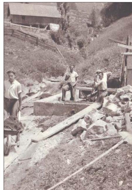
Erste Ergebnisse der harten Arbeit werden sichtbar: Die Grundmauern für das Maschinenhaus sind erstellt.
