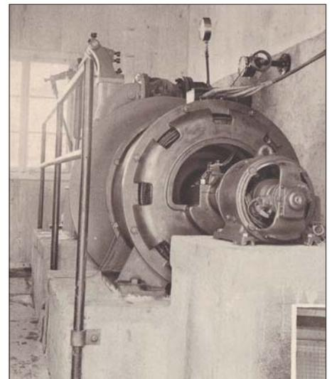
Das Herzstück der Anlage: ein 35-Kilowatt-Generator. Er erzeugte bis 1955 ununterbrochen Strom für das Bisistal.
