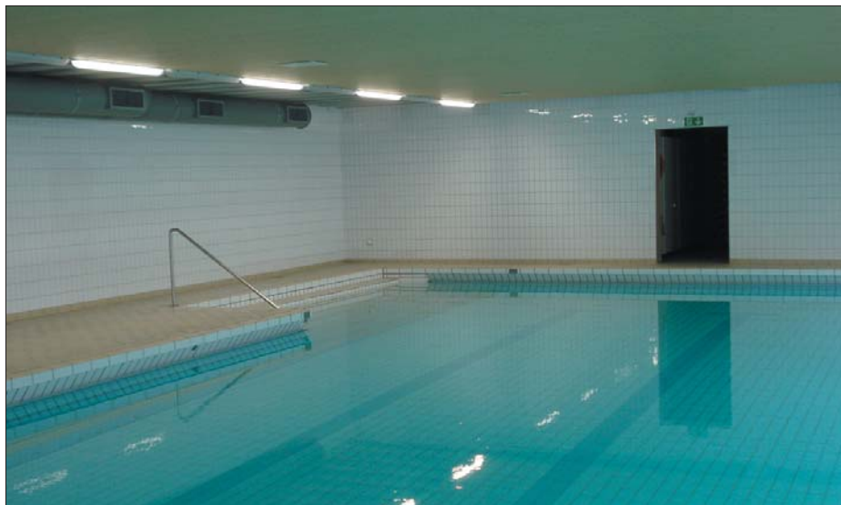
Bis letzten Herbst wurden der pH-Wert und die Desinfektion des Wassers mittels Salzsäure reguliert. Die Folge davon: Alles was mit der Salzsäure in Berührung kam, oxidierte, wurde zerfressen. Neu wird die Regulation mit Schwefelsäure und Chlorgranulat gemacht. Diese sind in der Lagerung und Anwendung viel weniger heikel.
