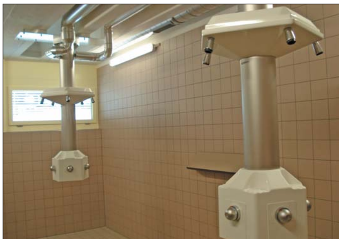
Die alten Wandduschen wurden durch zwei Duschsäulen ersetzt. Die Lüftungsrohre und die Warmwasserzufuhr sind neu «Aufputz» geführt. Das hat den Vorteil, dass Lecks sofort erkannt und mit viel weniger Aufwand und Kosten repariert werden können.
