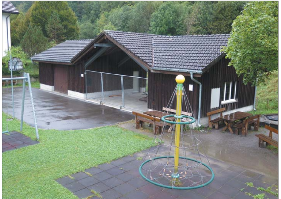
Das Regenklärbecken befindet sich unter diesem Gebäude im Wohnquartier Weid.
