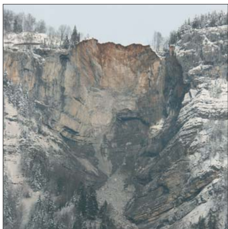
Die eindrückliche Abbruchstelle im Mettelbachtobel, wie sie sich am 27. November 2010 präsentierte.
