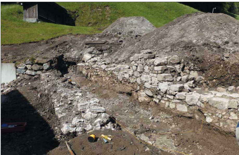
Auf dem Bild sind die Reste der beiden Friedhofsmauern zu sehen: links die neue und rechts die alte Mauer.
