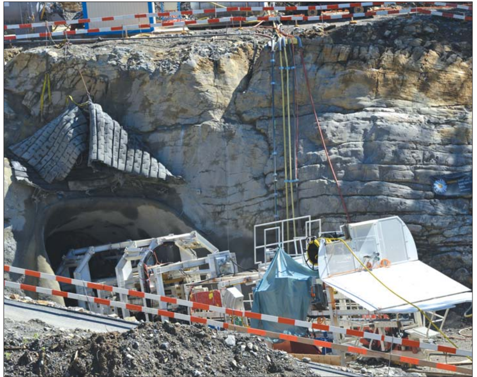
Von der 25 m langen Tunnelvortriebsmaschine aus werden die Sprenglöcher gebohrt und anschliessend mit Sprengstoff geladen. Nach dem Sprengen wird das ausgebrochene Material mit dem «Kolk» (fahrbare Materialmulde) rückwärts nach oben transportiert. Anschliessend werden die Anker gesetzt und der Spritzbeton auf die neu ausgebrochene Tunnelwand aufgetragen.
