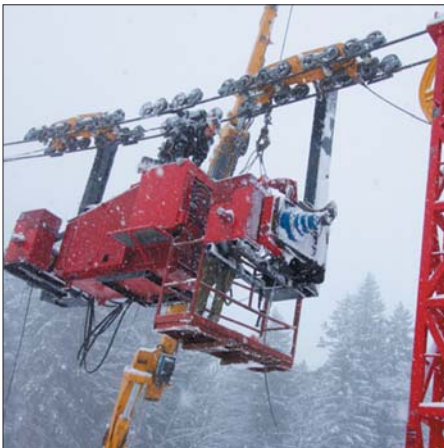
Unverzichtbar für den Bau der Standseilbahn: Die Materialseilbahn. Ihre Nutzlast beträgt 7.5 Tonnen, was umgerechnet 93 Personen entspricht.
