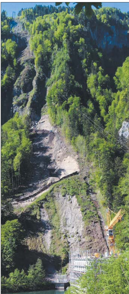
Baustelle neue Standseilbahn: Das komplett schnurgerade Trasse weist rekordverdächtige 110 Steigungsprozente auf. Die neue Standseilbahn wird künftig über diesen Hang und durch drei Tunnel auf den Stoos führen.
