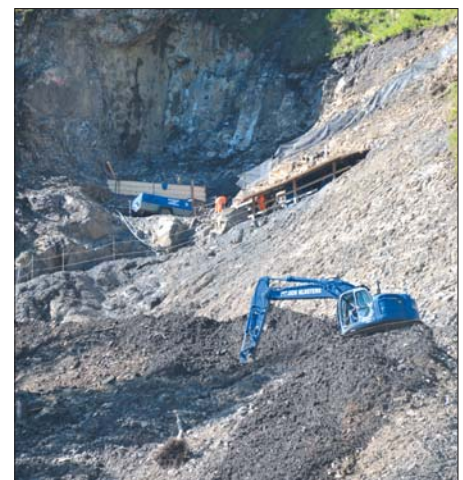
Eindrücklich und imposant, nur schon von den Dimensionen her, ist die Baustelle vor dem ersten Tunnel «Zingelfluh». Mit einem schweren Bagger werden im steilen Gelände Erdmassen verschoben.
