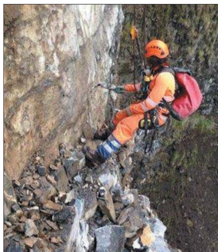
Arbeiten am Seil im Steilhang: Wie auf der Baustelle «Horärank» muss auch hier oft am Seil gesichert gearbeitet werden.
