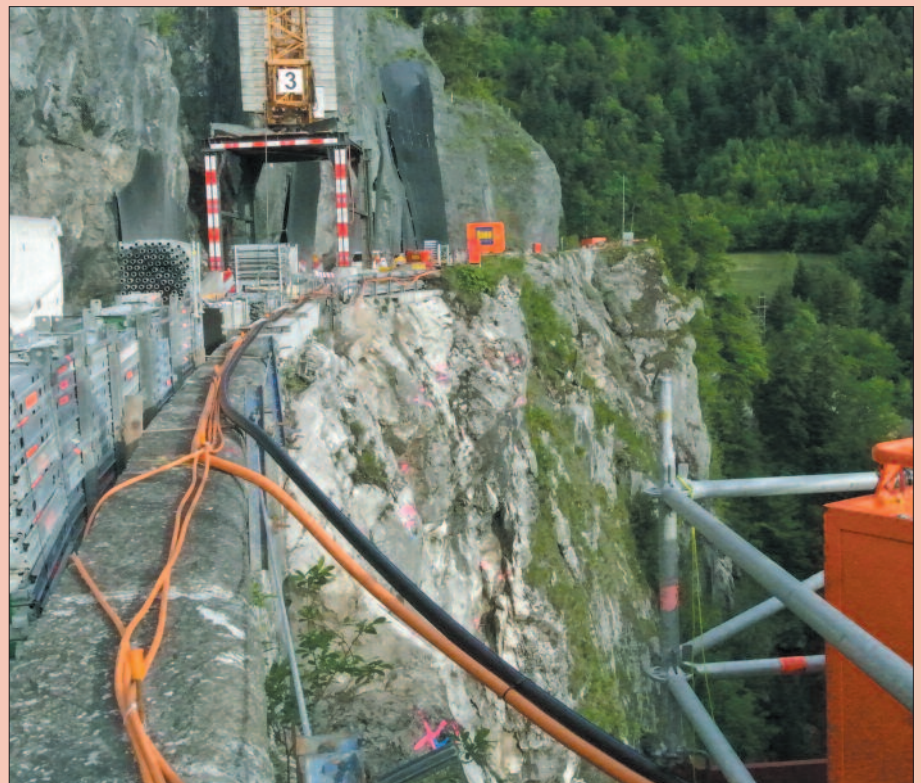
Insgesamt sechs Baukräne säumen die Grossbaustelle. Die Länge der Baustelle ist beeindruckend. Die engen Verhältnisse und die zum Teil gefährlichen Arbeiten über dem Abgrund stellen an die Bauleute hohe Anforderungen.
