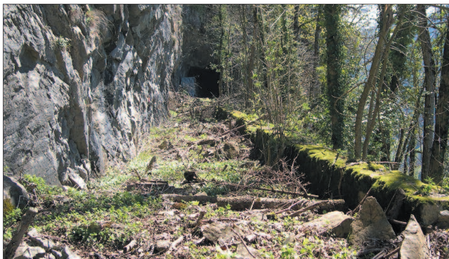
So präsentiert sich derzeit die alte «Strasse» in der Nähe des oberen Tunnels.
