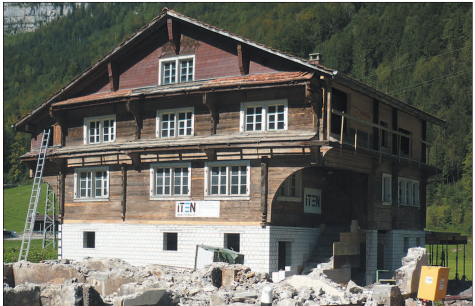
Einige Wochen nach der Verschiebung. Das 325jährige Haus von Rollen, Schienen und Sockeln befreit auf dem neuen Fundament.
