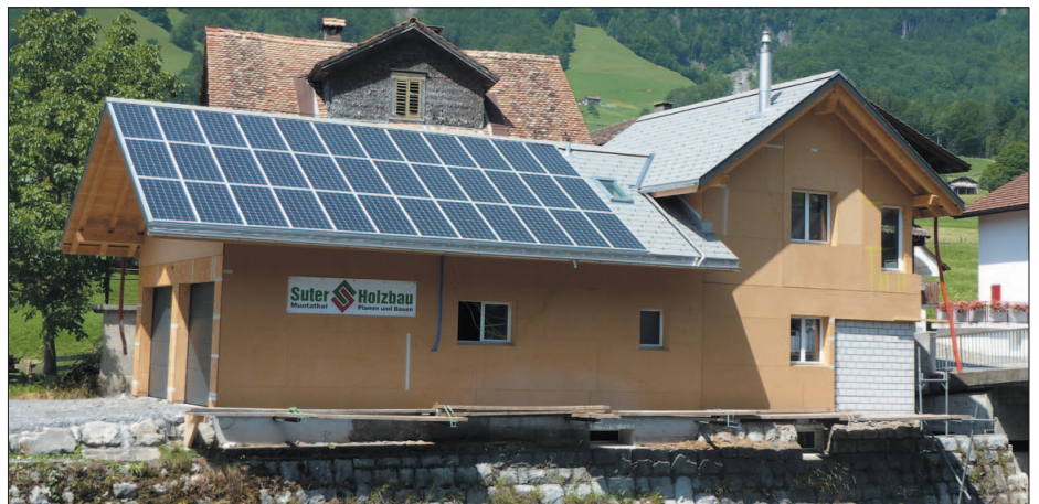
Das Allzweckgebäude von «Stützlers» Hubert neben der hinteren Brücke. Neue Technologien sinnvoll angewendet, leisten einen Energiebeitrag.
