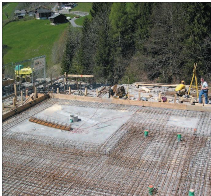
Bei diesem Hausneubau im Büel wird nach Fertigstellung der Eisen-Armierung die Bodenplatte betoniert.
