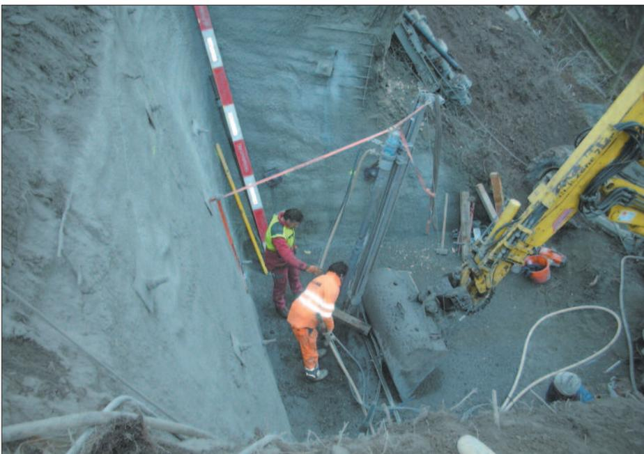
*Als Sofortmassnahme musste ein Stück instabile Stützmauer vorbetoniert und verankert werden.*
