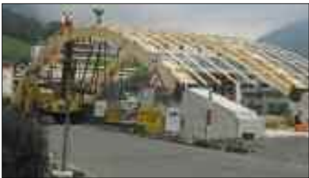
Die Zimmerleute der Arbeitsgemeinschaft Betschart, Suter, Suter beim Montieren der neuen Kirchenbrücke.
