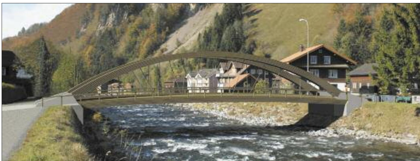
Auch wenn mir eine Stahl/Beton-Konstruktion lieber gewesen wäre, die neue Bogenbrücke überzeugt gestalterisch und ästhetisch.
