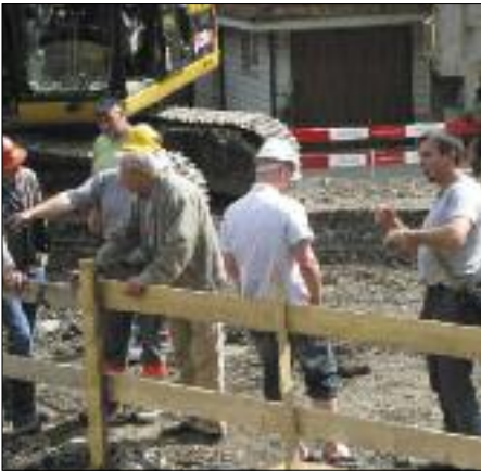
Die Bauleitung hat viel zu diskutieren.
