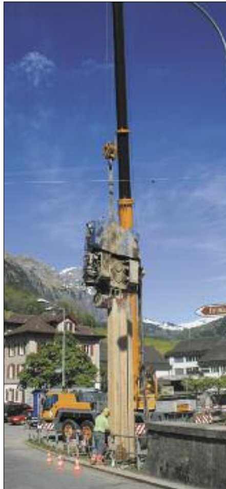
Die Larsen werden geschlagen und erzeugen Lärm.
