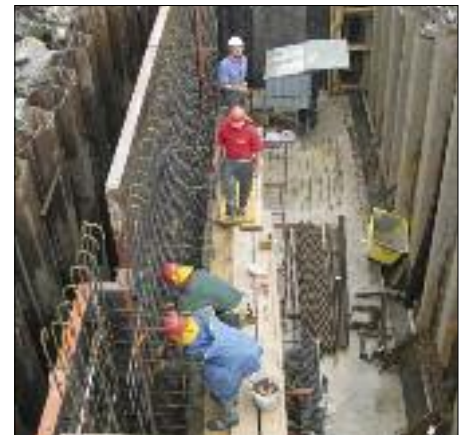
Armierung der Widerlager.
