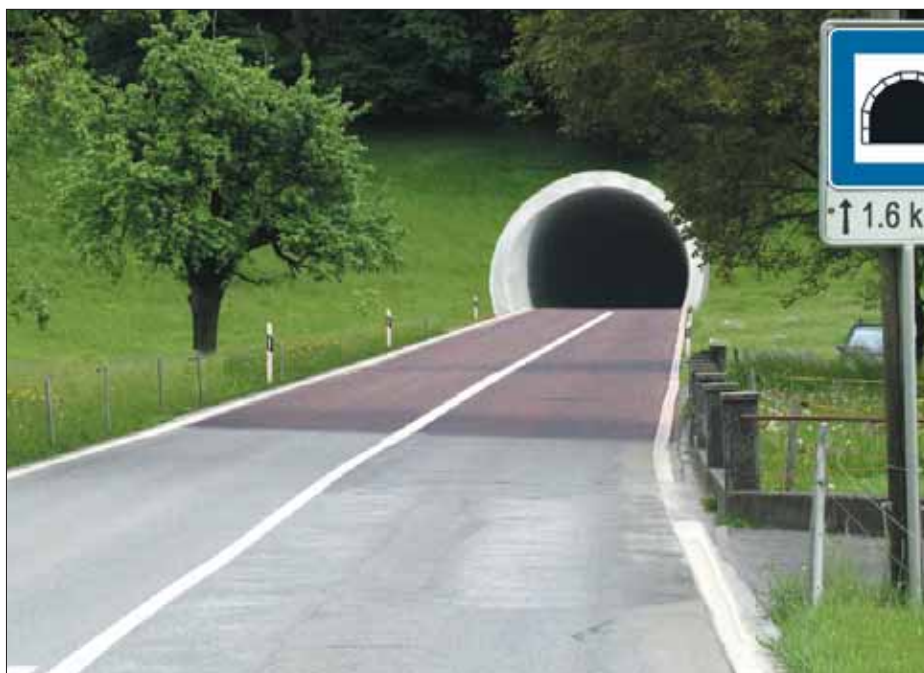
Mit einem Tunnel wäre eine sichere und wirtschaftsverträgliche Zufahrt ins Tal gewährleistet.
