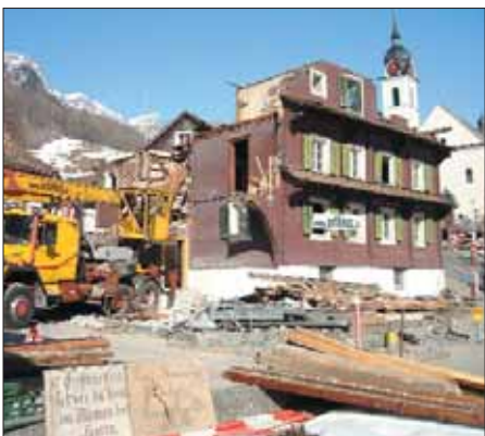
Das Pfarrhelferhaus kurz vor dem Abbruch.
