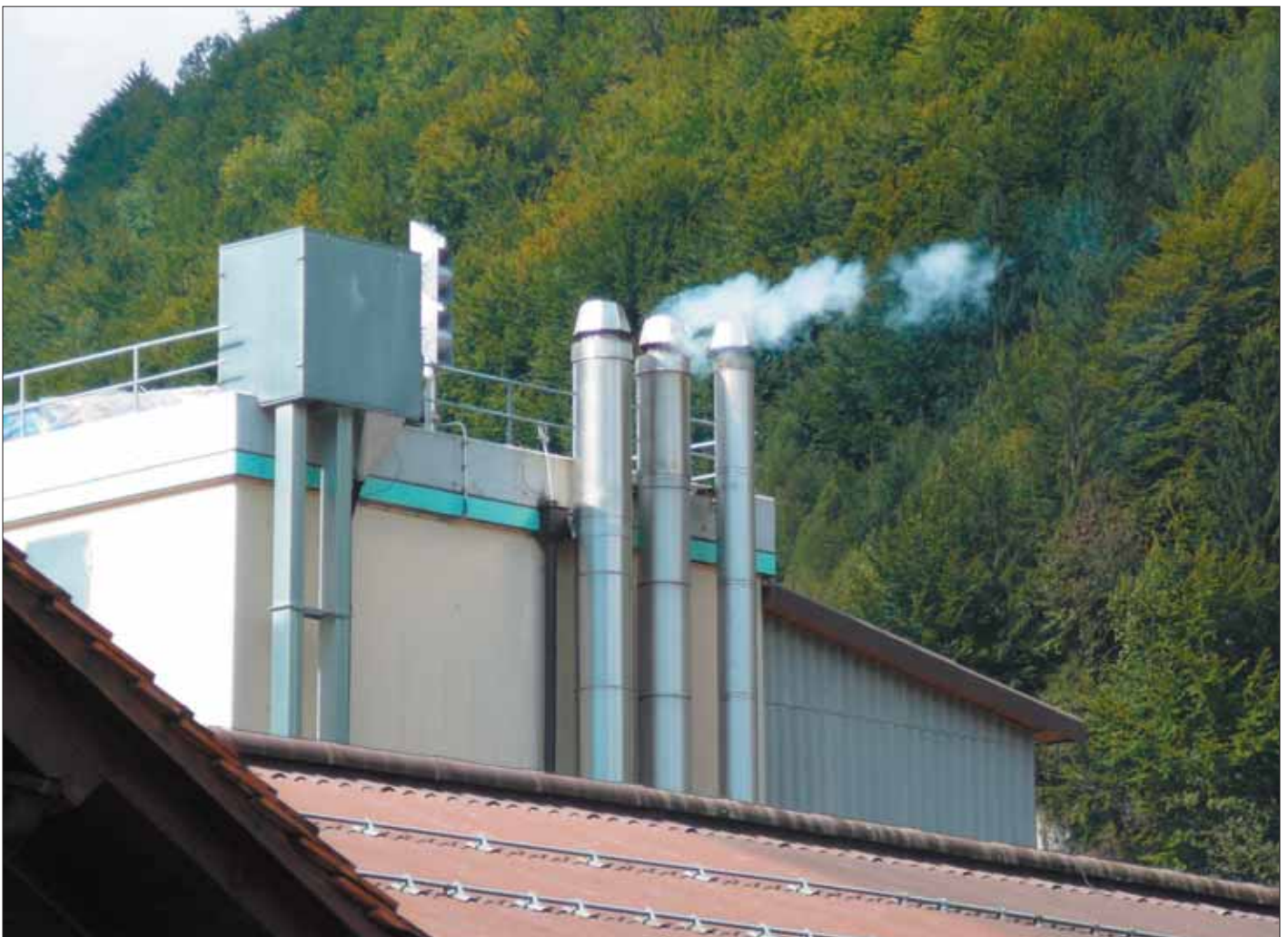
Kondensierter Wasserdampf entströmt dem Kamin, Russpartikel und Feinstaub werden vorher von der Rauchgaswaschanlage abgereinigt.
