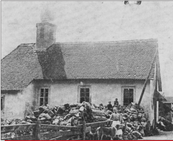
Die alte Kirche steht noch, aber bereits sind Steine gestapelt für den Neubau.
