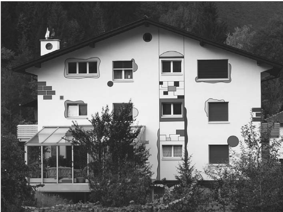
Südansicht der neu gestalteten Fassade.
