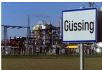
Biomassekraftwerk Güssing ( www.eee-info.net ).
