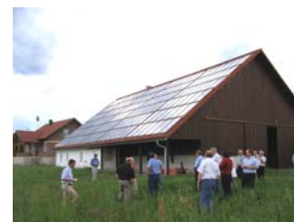
Die thermische Solaranlage in Urbersdorf liefert Energie für das lokale Fernwärmenetz.
