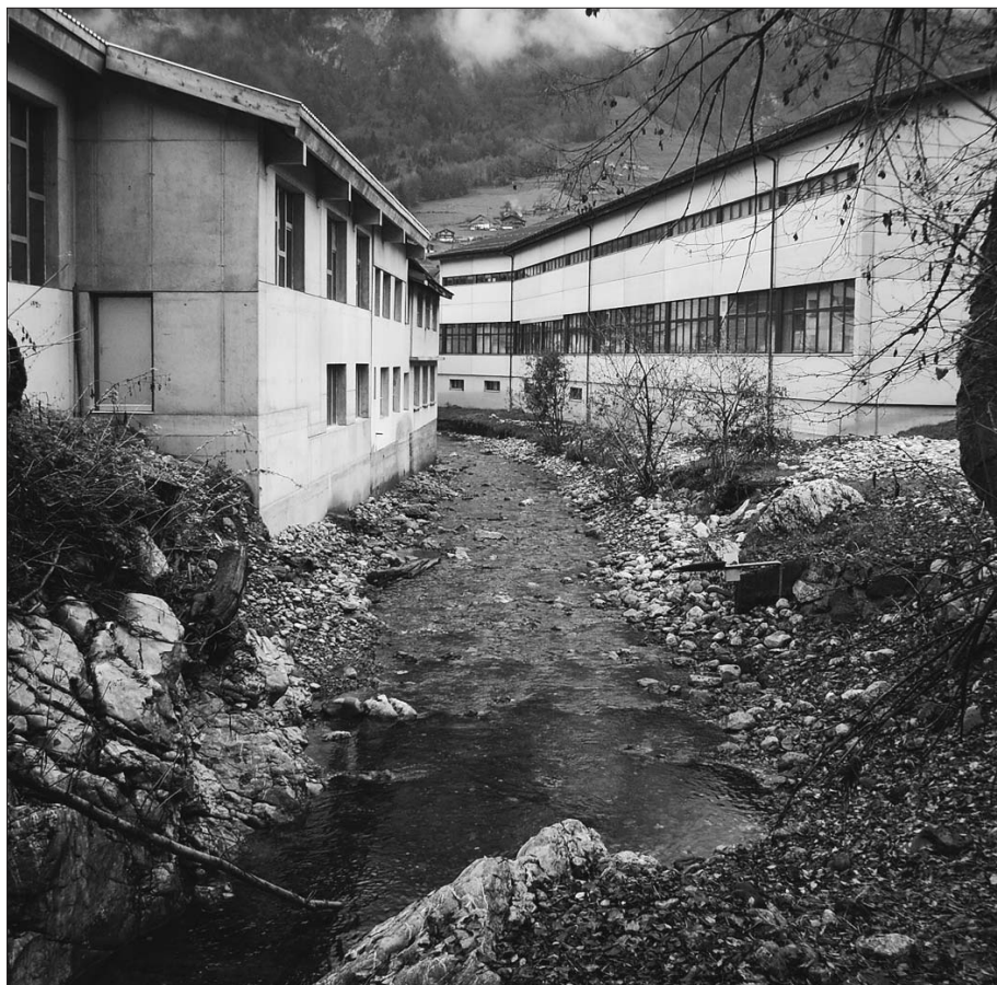
Diese Aufnahme zeigt eindrücklich, wie mit der Überbauung der Uferpartien beidseits des Hüribachs gesündigt wurde. Anstatt den gewaltigen Wassermassen eines Hochwassers, wie das vom 23. August 2005, Platz zu lassen, werden sie nun kanalisiert und donnern mit unvorstellbarer Geschwindigkeit und unheimlicher Urgewalt der Muota entgegen und erneuern nun in regelmässigen Abständen das Landrecht in den angrenzenden Betrieben.
