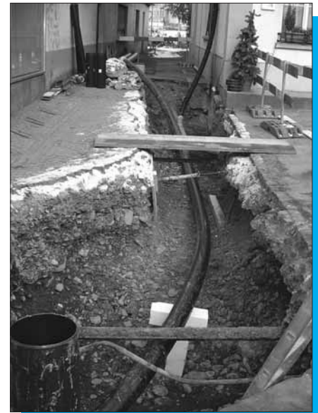
Leitungsbau mitten im Schachen.
