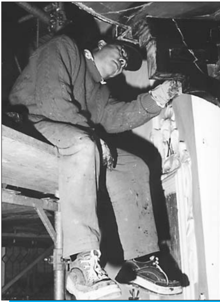
«Bilderchirurg» Herr Nguen bei den Freilegungsarbeiten an der Kanzel. Die oberen Farbschichten werden bis auf die ursprüngliche Farbe von 1792 abgetragen.
