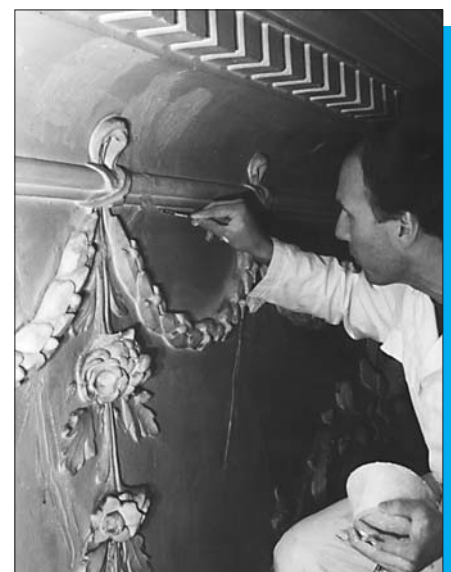
Der Stukkateur Herr Odermatt füllt die Risse im Gips aus und ergänzt schadhafte Stukk.
