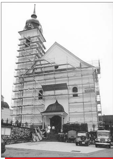
Die Restaurierungsarbeiten an der Pfarrkirche gehen planmässig voran.
