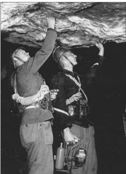
Installation des Telefons.
